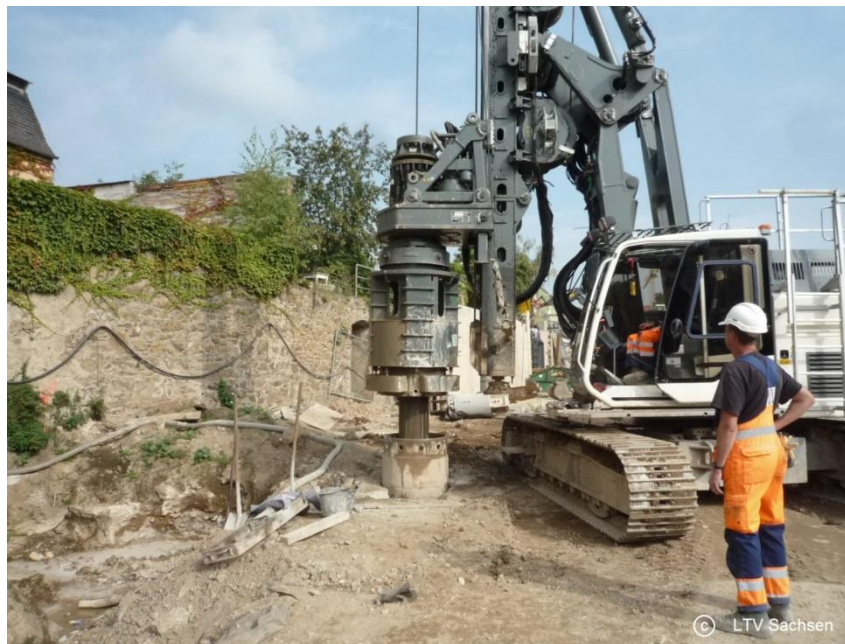
hloubení vrtu pro podzemní betonové těsnění
